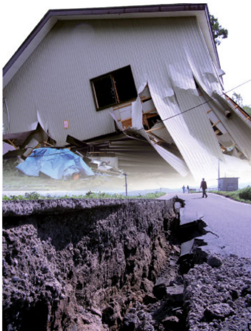
地震で倒壊した生産者の作業所(上)と、陥没し、ひび割れた道路(下) 2004年10月撮影
